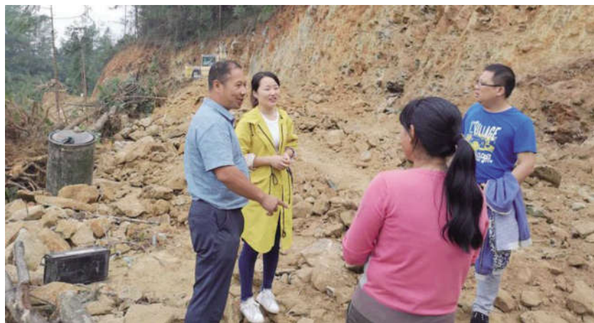
邹玖霖现场查看扶贫村毛坏路施工进度
