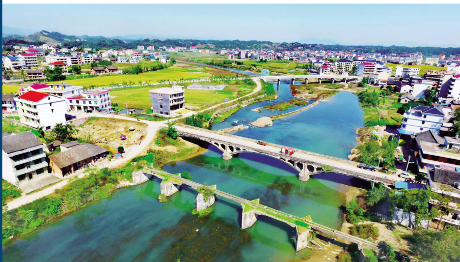
近处为古老的官渡桥，中间为向阳桥，远处为新桥。（杨升根/摄）
